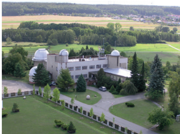
Solární a ozonová observatoř ČHMÚ v Hradci Králové je umístěna v budově Hvězdárny na Novém Hradci Králové. Foto: archiv ČHMÚ.
